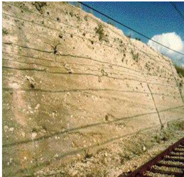
Figura 6 - Unità I vista dalla Ferrovia Cumana
